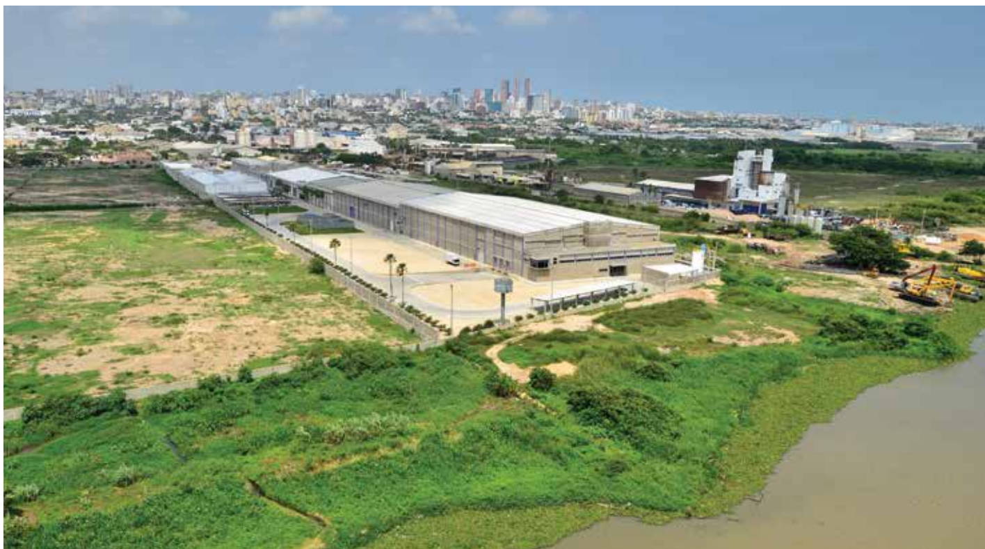
Planta de Sempertex en la zona industrial de Barranquilla.
